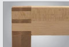
Fingerverzinkung in Hinterzange und Beiladerücken
