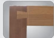
Schwalbenschwanzverzinkung in Hinterzange und Beiladerücken
